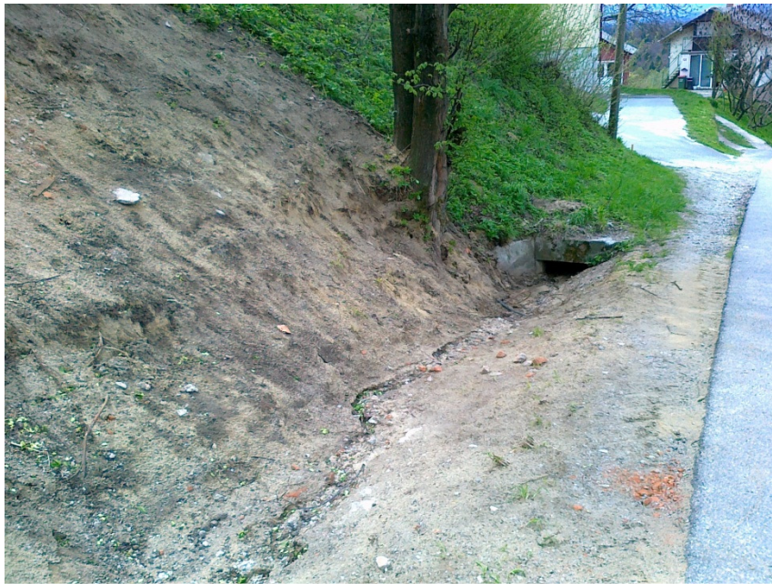
Nasipavanje izkopnega materiala na pobočje ob občinski cesti v Kremberku
