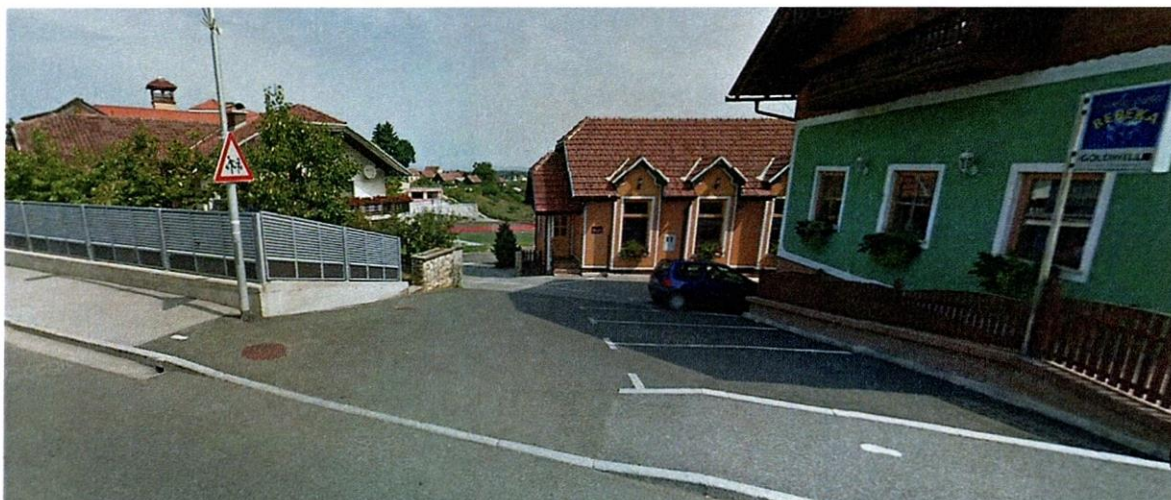
Pogled na lokacijo kotlovnice z regionalne ceste R3-730 Žice-Sv. Ana-Zg. Ščavnica
