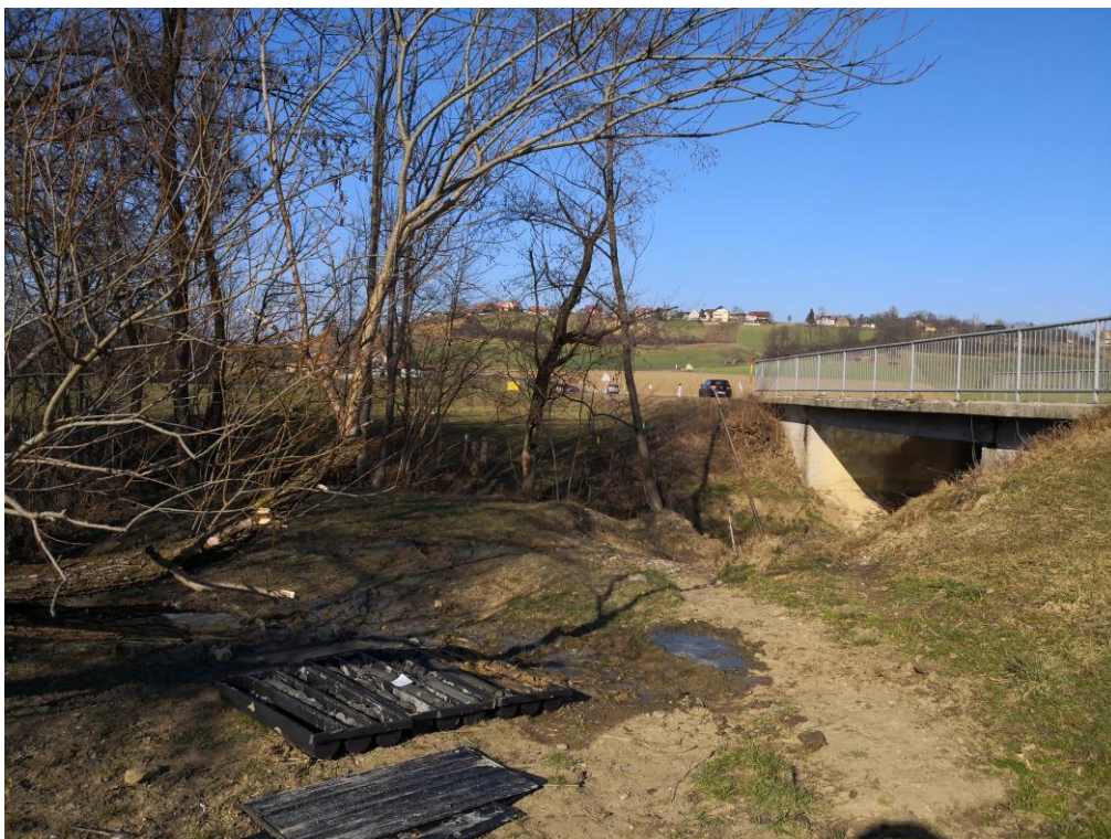
Slika 3: Pogled na območje mostu D1
