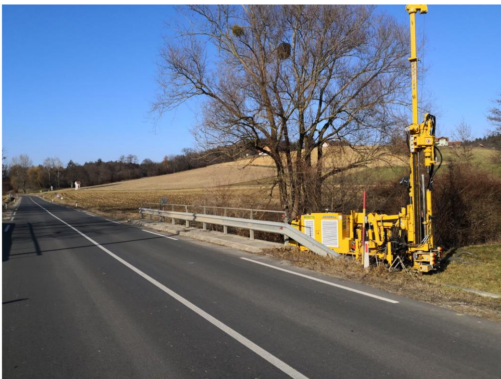
Slika 4: Pogled na območje mostu D5
